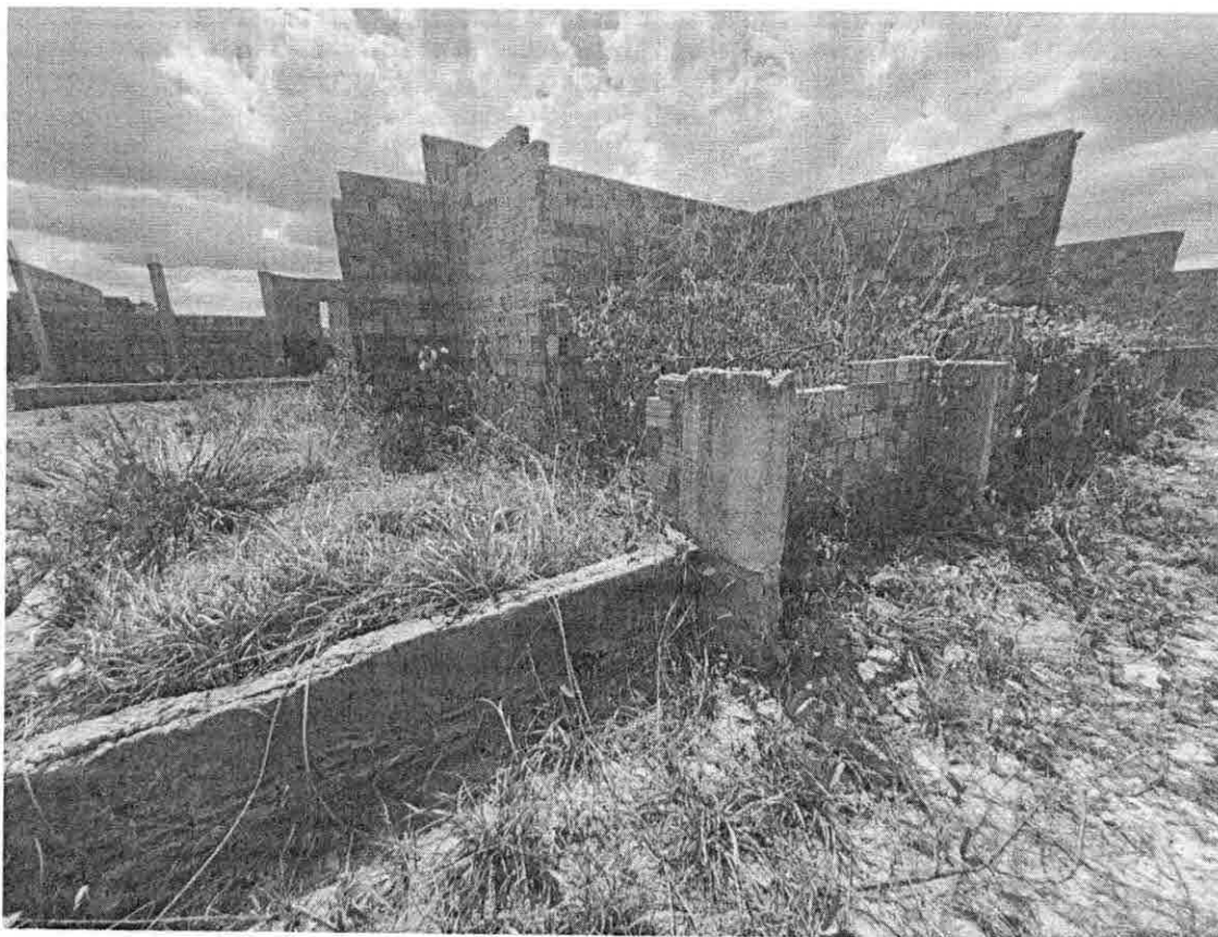
Figura 19 – Alvenaria utilizada como nivelamento da viga baldrame
