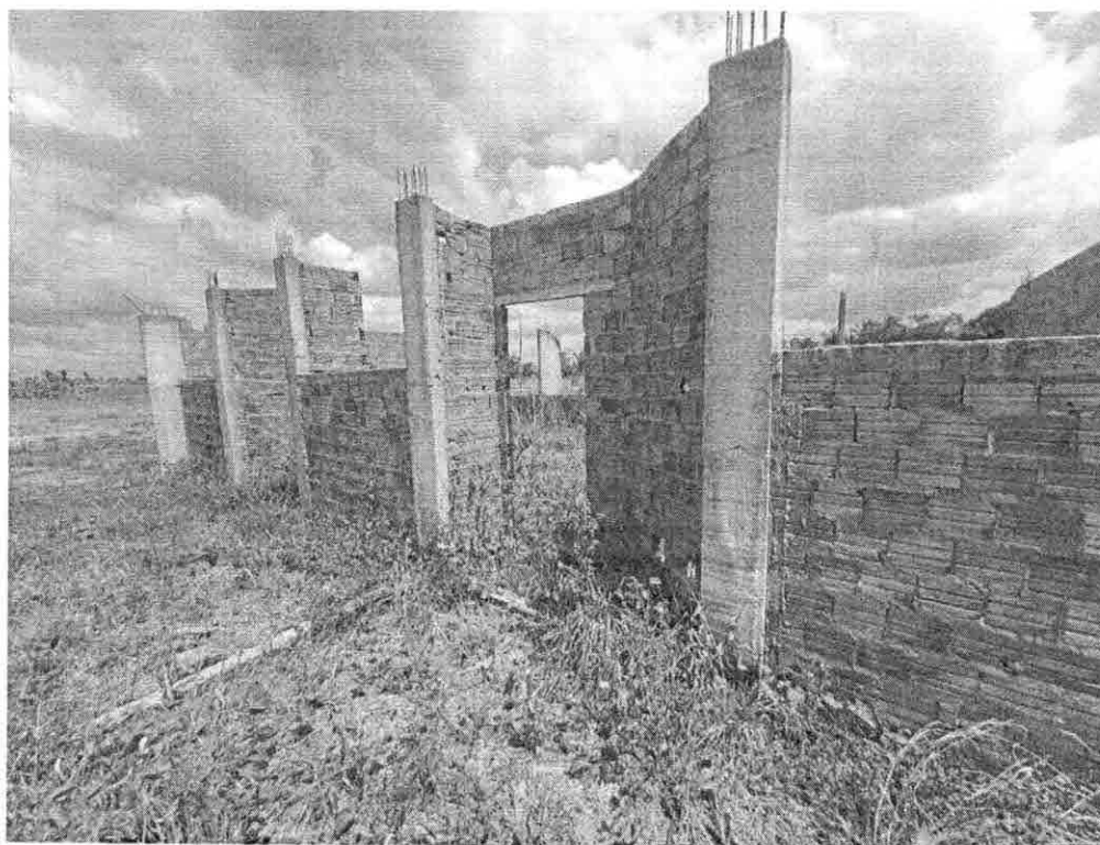
Figura 28 – Pilar concretado com bicheira
